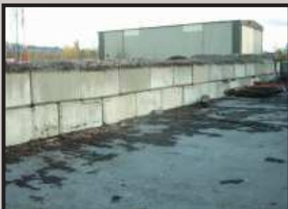
(100+) CONCRETE LOCK BLOCKS
